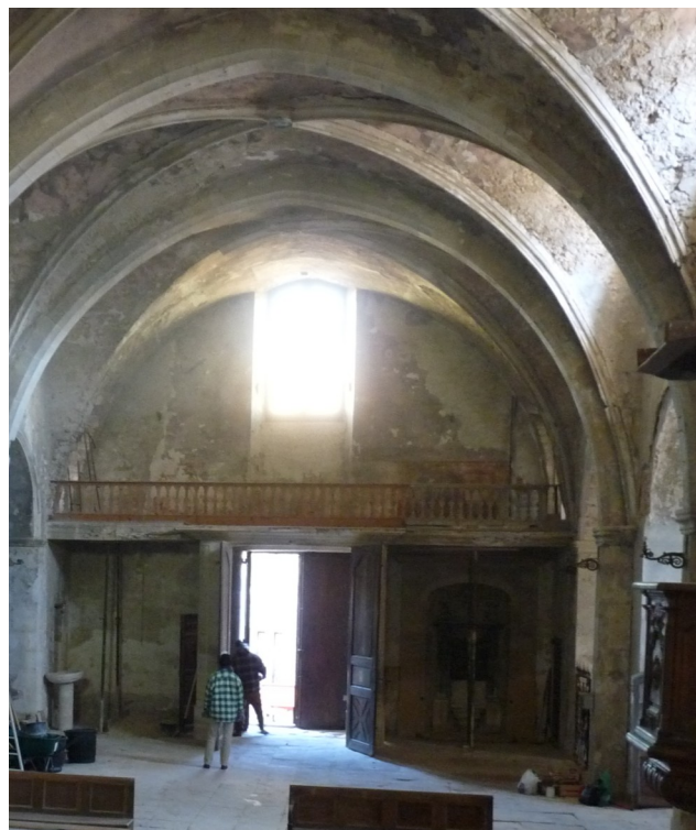
Vue de l'entrée principale depuis l'intérieur, tribune et tambour
